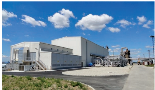
Slika 4. Kompresorska stanica za ugljični dioksid na CPS Molve
