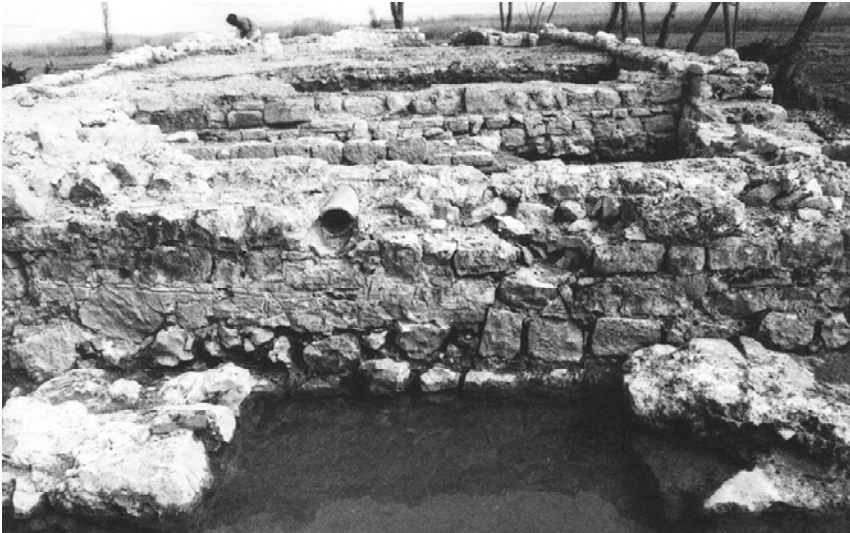
Sl. 15. Pogled od vanjskog zida nartekse u pročelju crkve prema začelju crkve, vide se zidovi koji su prethodili crkvi i podnica crkve (1993.). Fig. 15. Vue depuis le mur extérieur du narthex sur la façade vers le chevet de l'église; on remarque les murs précédant l'église et le sol de l'église (1993).
