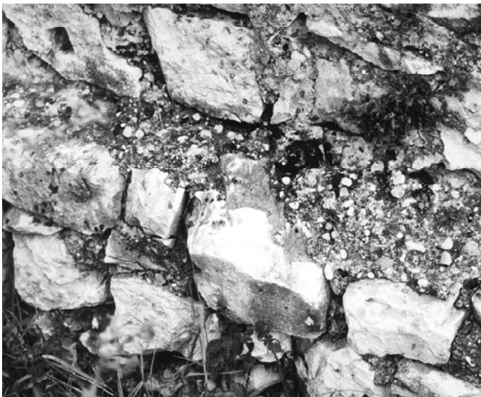
Sl. 34. Korintski kapitel iz 3. st. uzidan u sjeverni zid crkve, u njegovu temeljnu stopu; vidi se sastav likadine.
