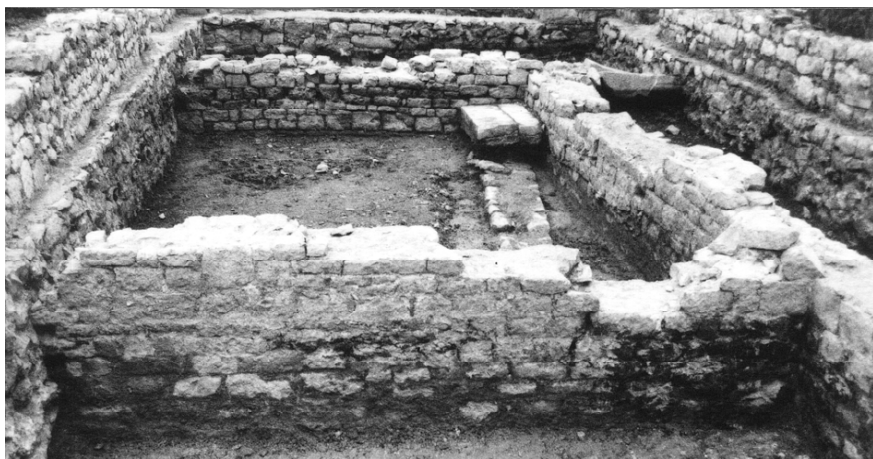
Fig. 22. Vue de la façade de l'église vers le chevet; on remarque les murs de la villa qui lui on précédé; à gauche, partie du sol qui a subsisté dans le narthex (1996).
