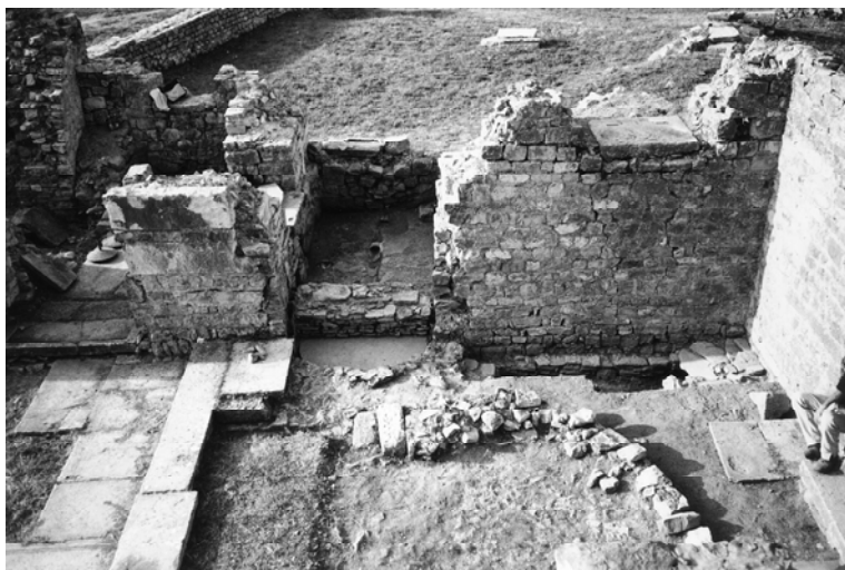
Slika 8. Pogled na prostor I.5. Vidljivo je kako je zid I.103 probijen i na njegove rubove prislonjen zid eksedre (foto: T. Dabac)
