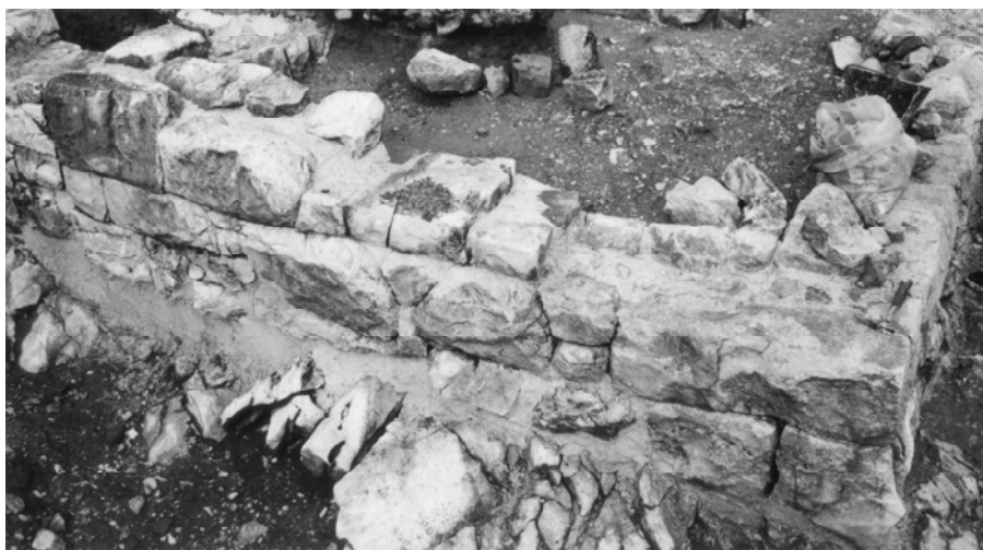
Sl. 12. Konsolidacija zidova helenističke građevine.
