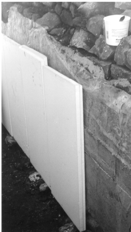
Sl. 1. Preventivni zaštitni radovi 1998. (osiguravanje žbuke i zida A3 hrama).
