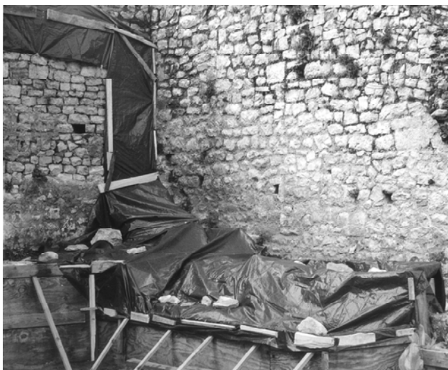
Sl. 2. Preventivni zaštitni radovi 1999. (zidovi A3 i A4 nakon pokrivanja).
