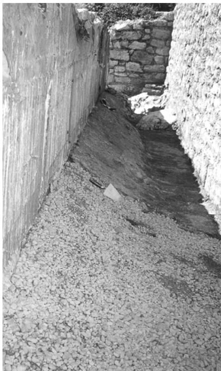
Sl. 9. Rekonstrukcija odvodnog kanala između zida A3 i A4 hrama.
