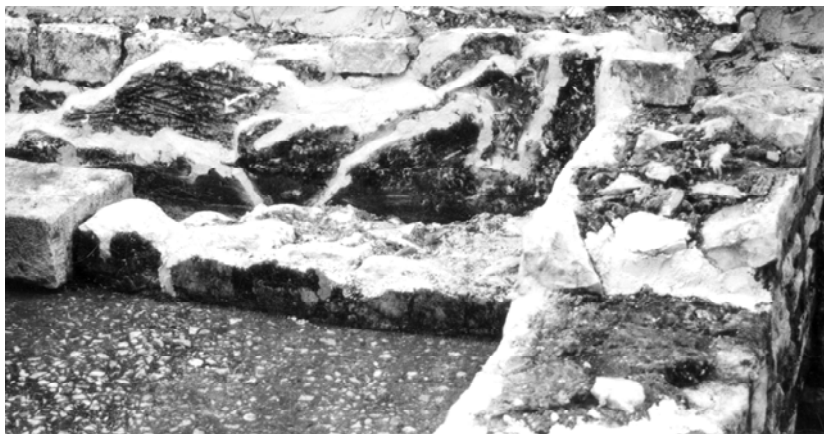
Sl. 13. Oslíkana višeslojna žbuka u četvrtastoj prostoriji, po sredini zida A12, nakon konzervacije.
