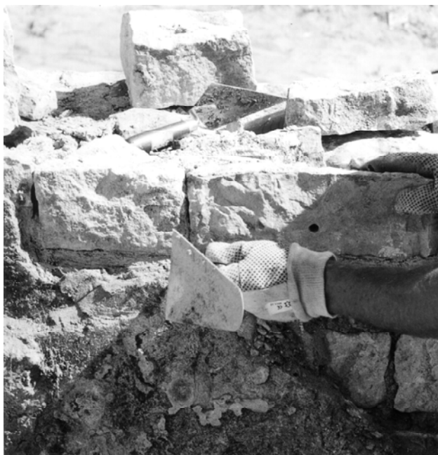
Sl. 4. Fugiranje zidova hrama novom žbukom.
