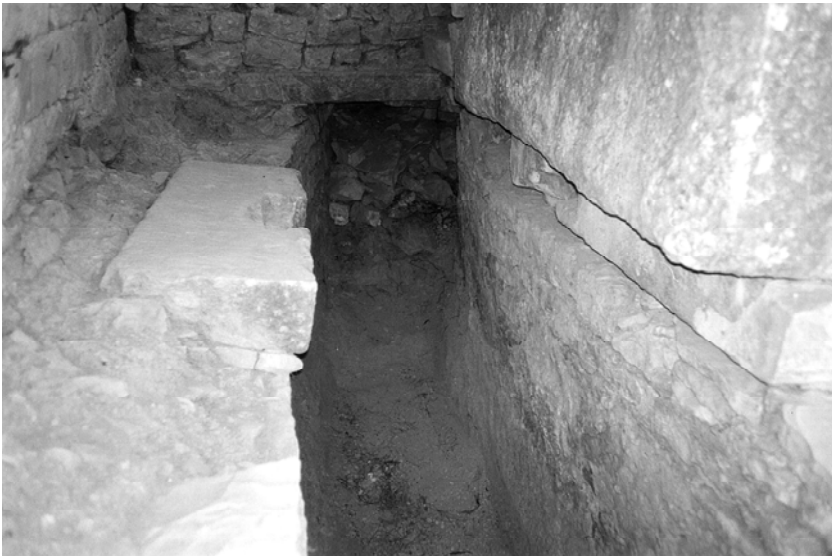
Sl. 13. Tragovi osovine vodeničkog kola na ploči iznad kanala vodovoda. (Foto: J. Mardešić)
