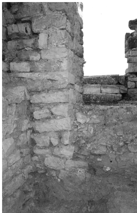
Sl. 9. Jedan od južnih kontrafora «Oratorija A». Kontrafor je izgrađen iznad ranijeg zida. (Foto: J. Mardešić)
