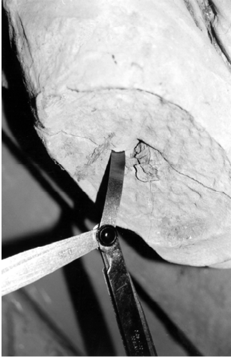
Sl. 10. Mjerenje širine raskukline mramora uslijed oksidacije željeznog tma
