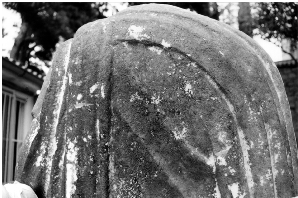
Sl. 5. Torde i debele kalcitne kore prije tretmana čišćenja
