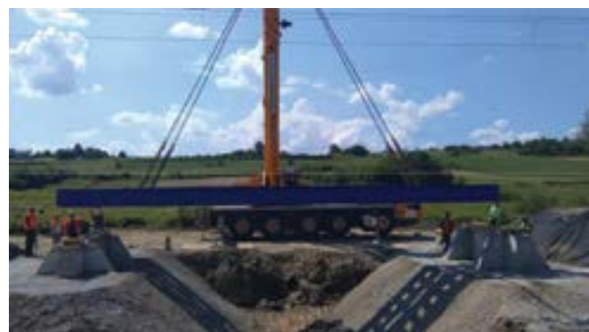
Slika 15. Ugradnja provizorija na dionici pruge Križevci – Dugo Selo
