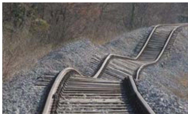
Slika 2. Klizište na dijelu pruge u Istri (foto: Goran Brumnić)
