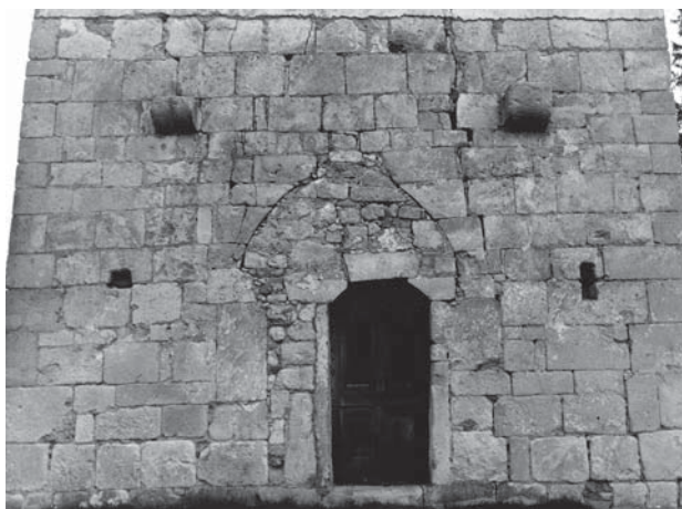
34. Zapadno pročelje zvonika prije rekonstrukcije izvornih vrata / Western bell tower facade before the reconstruction of the original doors
