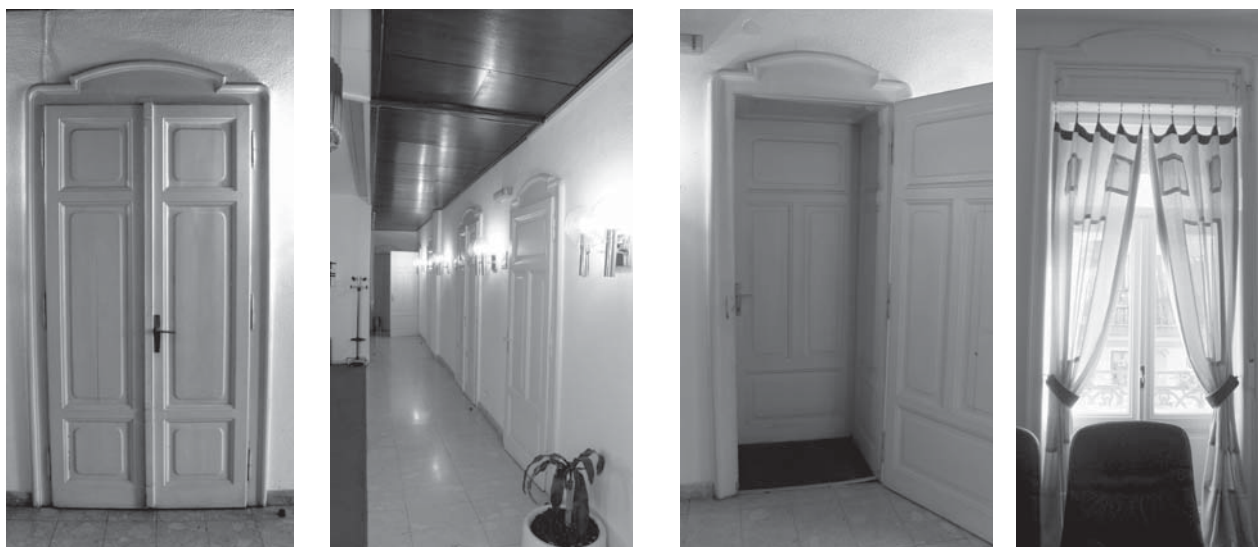
Detalji hodnika, prozora i vrata unutrašnjeg prostora ex hotela Royal / Hall, windows and room doors details of ex hotel Royal
