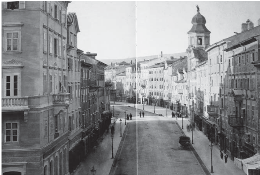
Izgled Korza na mjestu prije izgradnje hotela Royal / Korzo before the construction of the Royal Hotel
