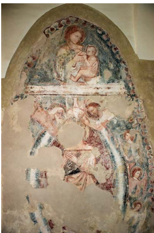
16. Šenkovec kraj Čakovca, kapela sv. Jelene. Detalj oslika s mnoštvom natučetina na sjeveroistočnom zidu kapele, primjer reintegracije žbuknog sloja u lacunama (Fotografirao: Vidoslav Barac, 2000.) / Šenkovec close to Čakovec, St. Helen's Chapel. Detail of the painted surface with a lot of chipped parts on the north eastern wall of the chapel, example for the reintegration of the plastered layer in the lacunas (Photo: Vidoslav Barac, 2000)
