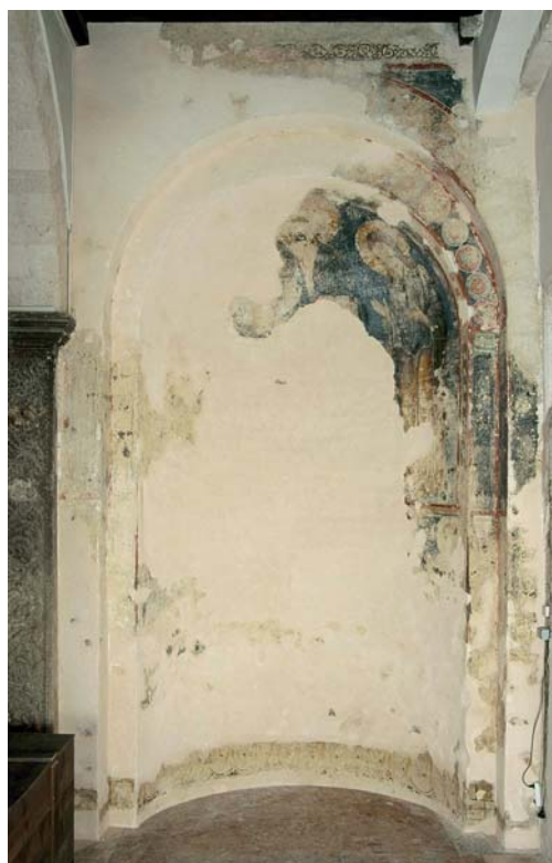
21. Zadar, katedrala sv. Stošije. Južna apsida, stanje nakon radova, primjer reintegracije žbukanog sloja u lacunama (Fotografirao: Jovan Kliska, 2008.) / Zadar, St. Anastasia's Cathedral. Southern apse, post reconstruction state, example for the reintegration of the plastered layer in the lacunas (Photo: Jovan Kliska, 2008)
