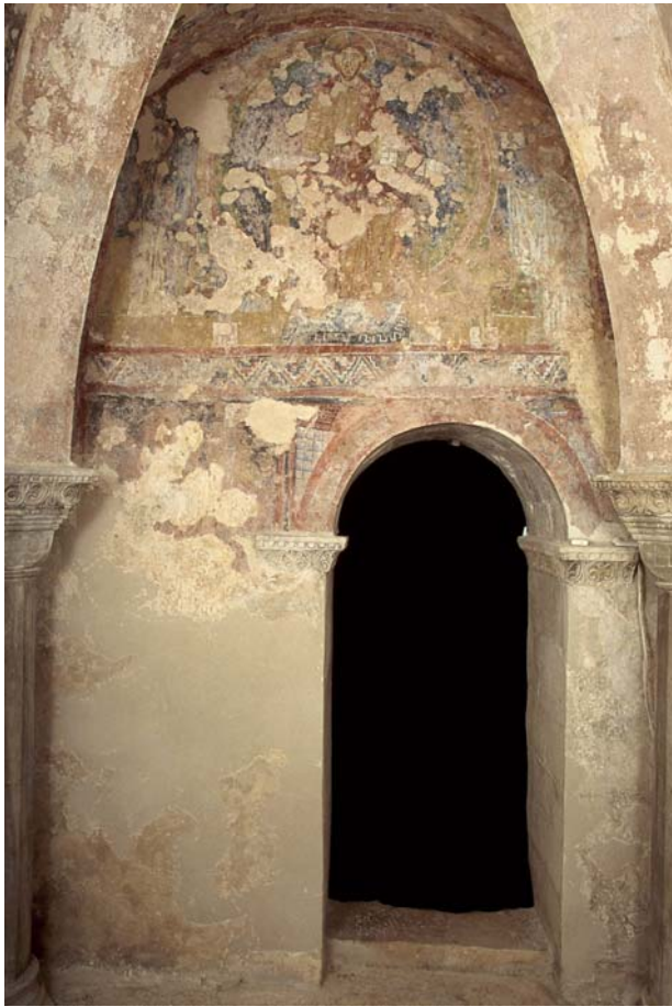
19. Zadar, zvonik crkve sv. Marije. Jugoistočni zid, primjer reintegracije žbukanog sloja u lacunama. (Fotografirao: Jovan Kliska, 2008.) / Zadar, St. Mary's Church bell tower. South eastern wall, example for the integration of the plastered layer in the lacunas. (Photo: Jovan Kliska, 2008)
