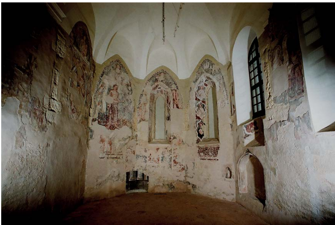
13. Šenkovec kraj Čakovca, kapela sv. Jelene. Pogled na unutrašnjost kapele s ostacima zidnih slika. (Fotografirao: Vidoslav Barac, 2000.) / Šenkovec close to Čakovec, St. Helen's Chapel. View of the chapel interior with the remains of wall paintings. (Photo: Vidoslav Barac, 2000)
