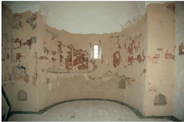
22. Lovčić, kapela sv. Martina. Stanje nakon radova, primjer reintegracije žbukanog sloja u lacunama (Fotografirao: Ivan Srša, 2009.) / Lovčić, St. Martin's Chapel. Post reconstruction state, example for the reintegration of the plastered layer in the lacunas. (Photo: Ivan Srša, 2009)
