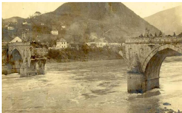
Slika 8. Srušena dva stuba i lukovi koji su se na njih oslanjali (1915.-1916. godina) [5]
