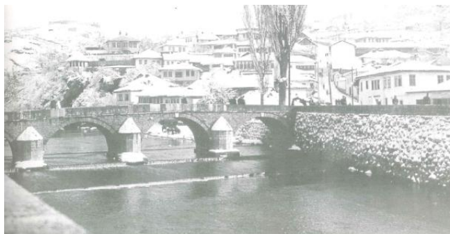
Slika 19. Most prije skidanja kamene ograde-korkaluka [21]
