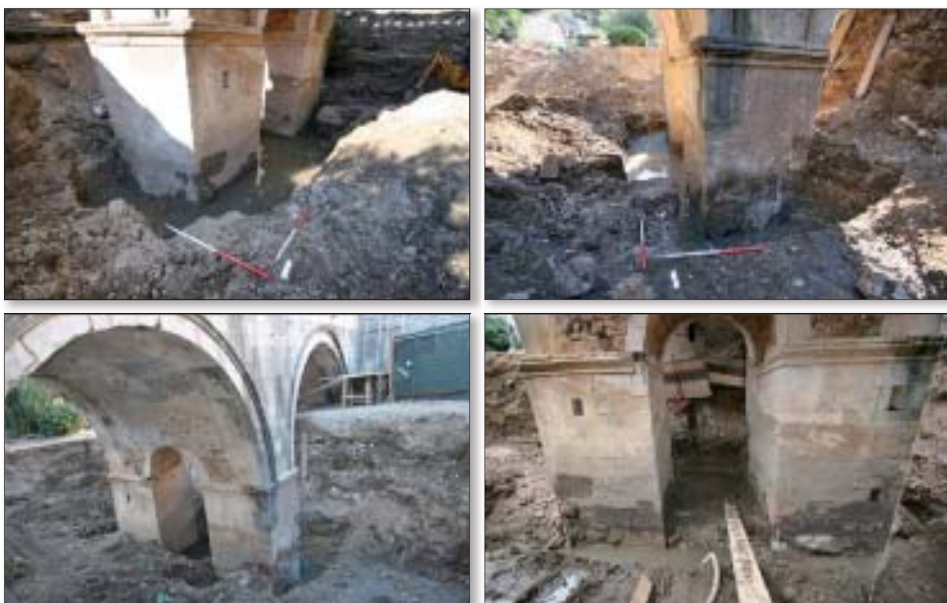
Slika 23. Pogled na otkopani zapadni par pilona
