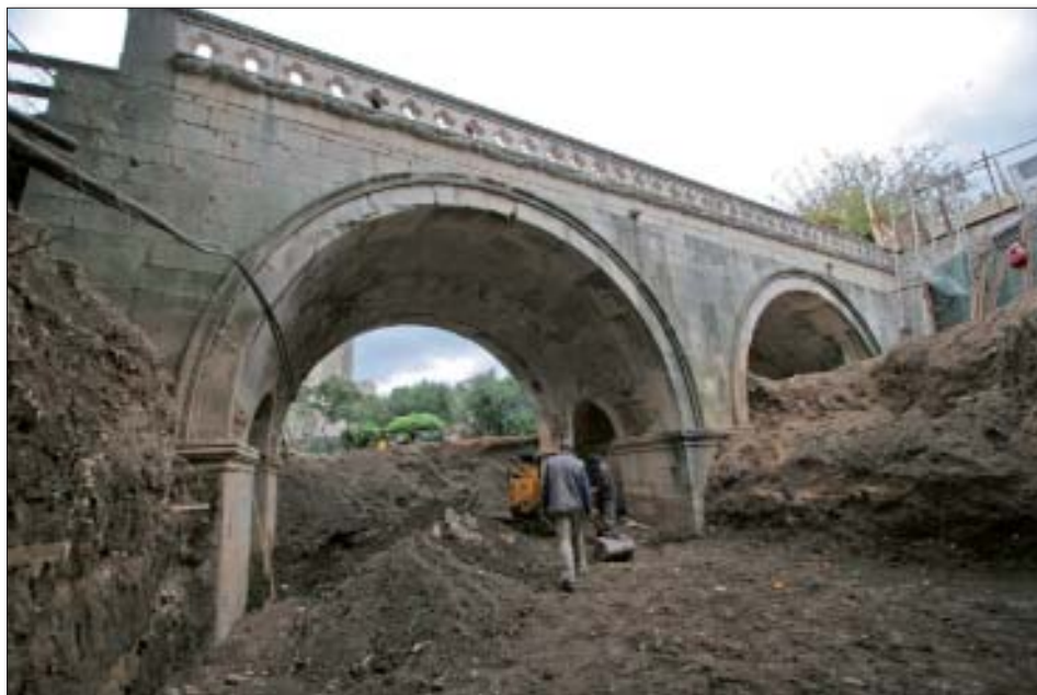
Slika 14. Pogled na most odozdo
