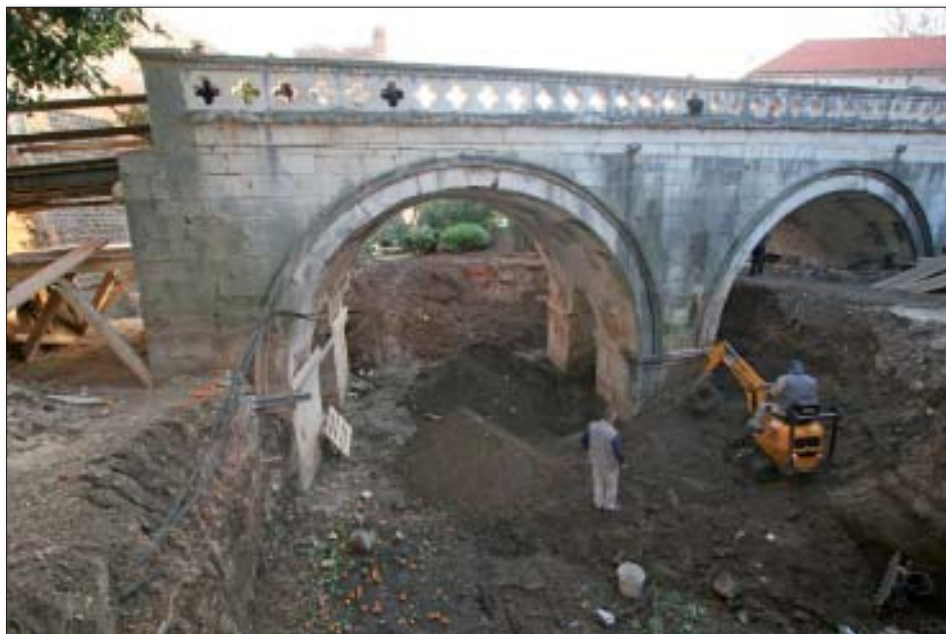
Slika 15. Pogled na most (S-J)
