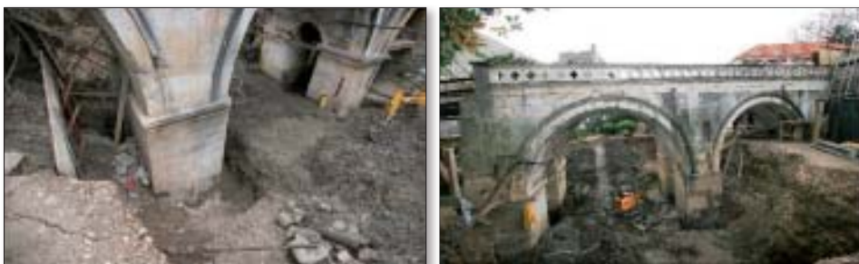
Slika 24. Pogled na zadnju razinu otkopavanja pilona mosta - pješčani sloj s manjom količinom nalaza
