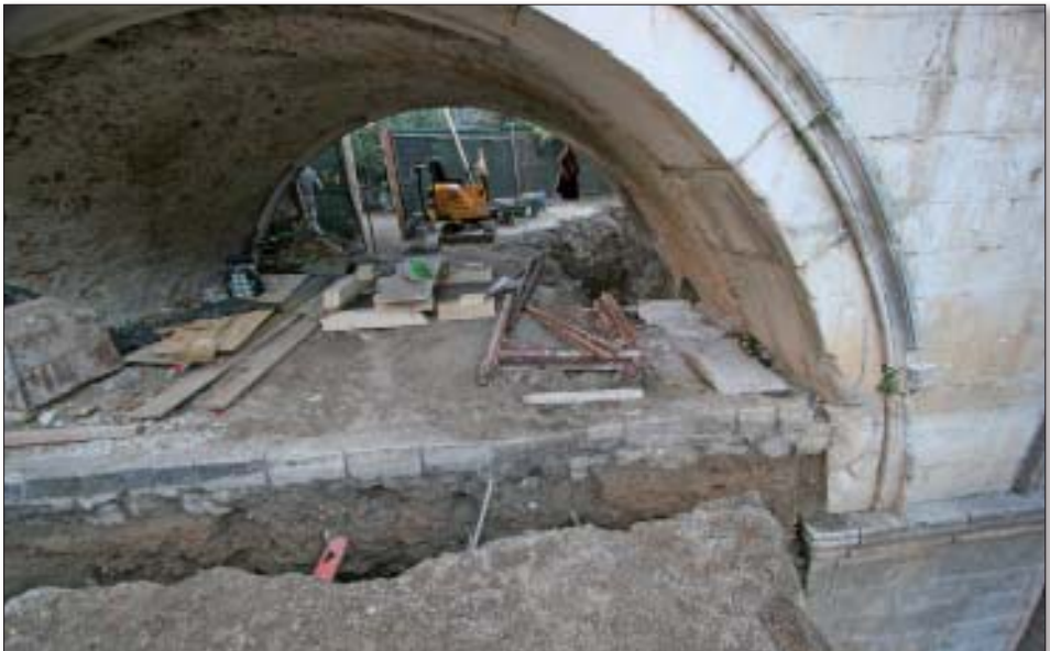
Slika 17. Nasip pod zapadnim lukom mosta
