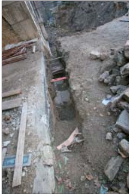
Slika 16. Kontrolni kanal s južne strane zapadnog luka
