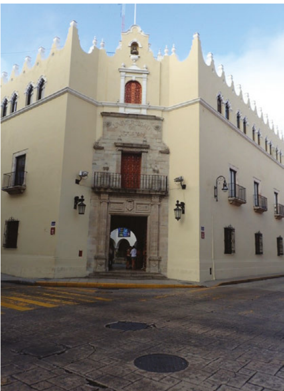
Zgrada sveučilišta Yucatan u Meridi. Foto: Branko Jalžić
