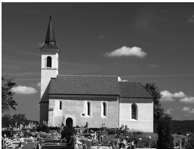
1. Pogled na južno pročelje kapele sv. Križa u Križu Gornjem (foto: G. Bekina, Konzervatorski odjel u Bjelovaru, 2012.) / View of the south façade of the Chapel of the Holy Cross in Križ Gornji (photo: G. Bekina, Conservation Department in Bjelovar, 2012)
