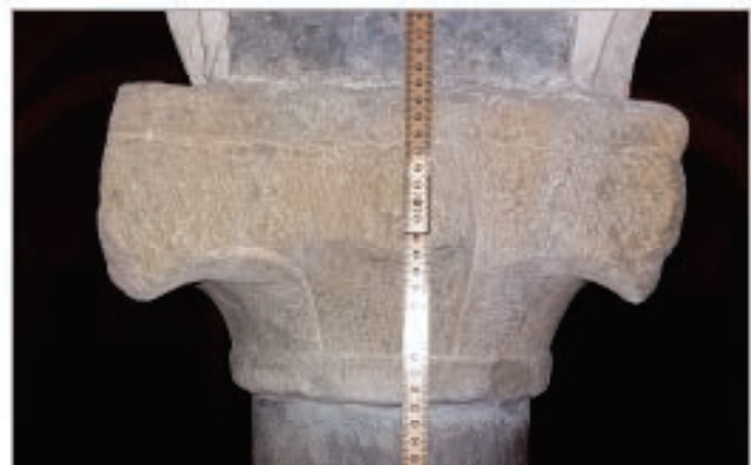
Capitello conico con volute non ancora lavorate e tre foglie appena sbazzate
