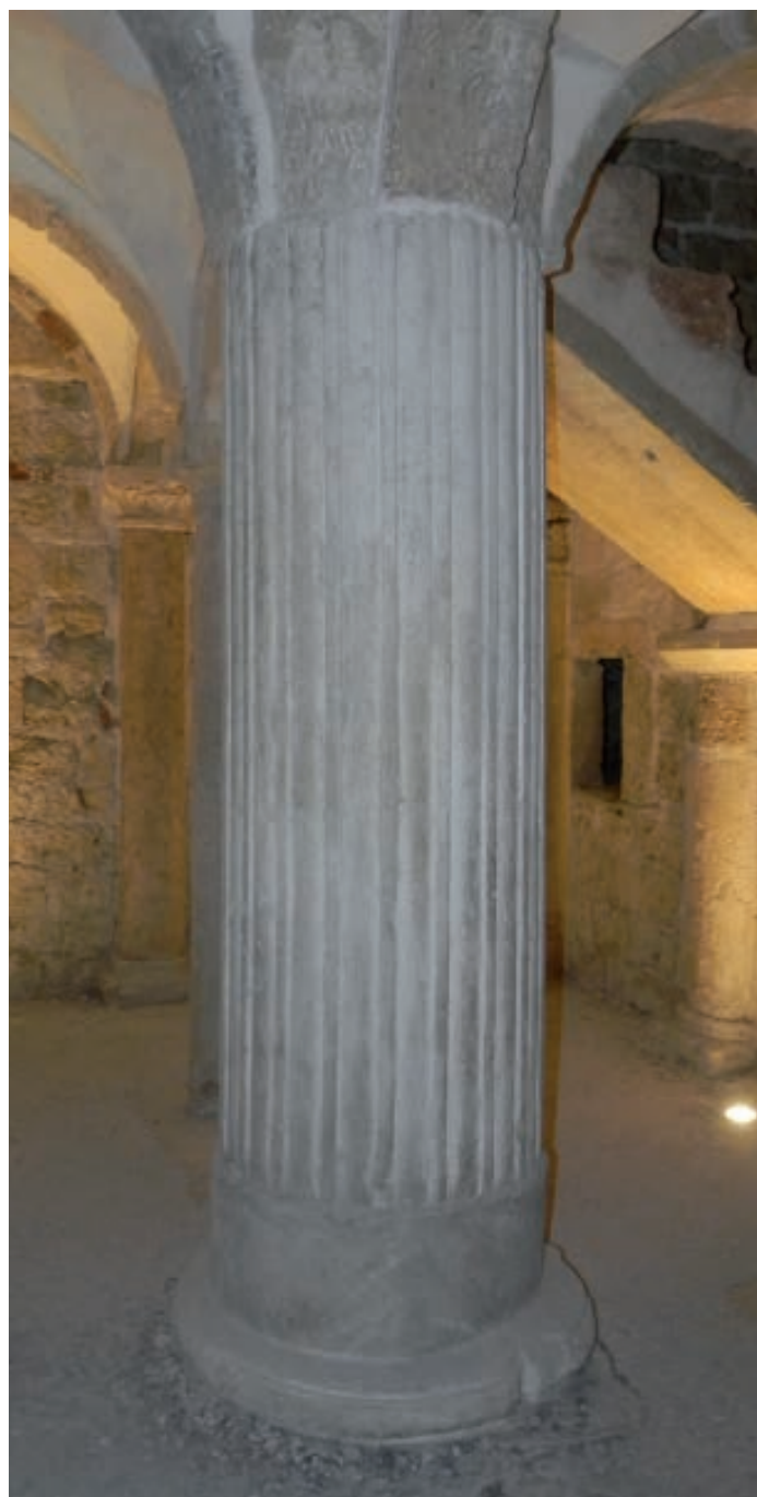
Chiesa di San Salvatore in Brescia, aula della cripta, particolare di un fusto di colonna scanalata e rudentata. Nella parte superiore del fusto si nota come siano state scalpellate le scanalature per ricavare l'appoggio delle arcate delle voltine di copertura dell'oratorio.
