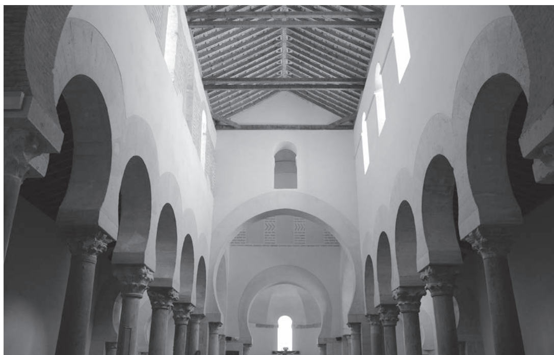
Fig. 11 Interior de la iglesia de San Cebrián de Mazote (Valladolid): un edificio del s. X de planta basilical dotado de tres naves cubiertas con madera, que fue prácticamente destruido en su totalidad durante la Guerra Civil española (1936-1939). En este monasterio, fundado por monjes procedentes de San Martín de Castañeda, aparecen por vez primera los 'capiteles de la serie leonesa', entre los años 920-940 (© Ángela Crespo Espinel).
