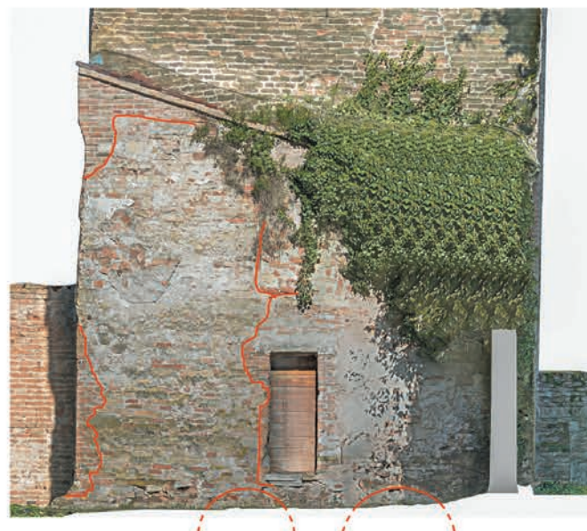
2. Parete sud del campanile, parete del perimetrale nord della chiesa
