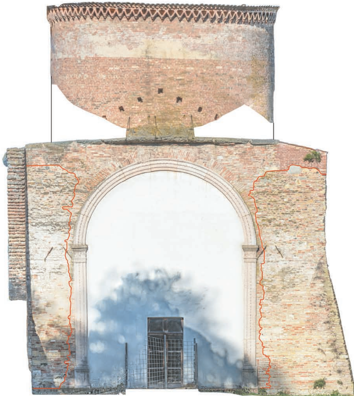
Fig. 7. Vangadizza, Santa Maria, tratto verso ovest del perimetrale nord, tagliato dalla cappella cinquecentesca.
