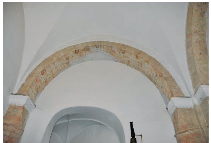
Fig. 20. Carceri, Santa Maria, navatella laterale sud. I pennacchi delle volte a crociera si impostano su semicolonne con collarino, capitelli cubici in laterizio (quello di nord ovest della navata nord ha tracce di decorazione a fresco a linee parallele) e cornici in pietra a gola, decorate da una duplice dentellatura.
