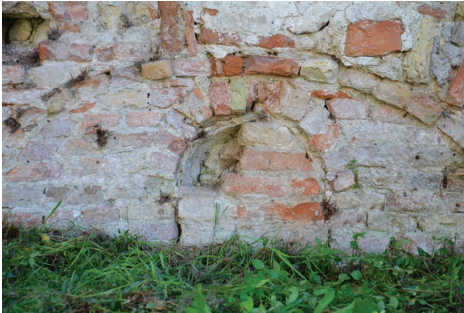
Fig. 10. Vangadizza, Santa Maria, finestra tamponata al di sotto di un arco della cripta.
