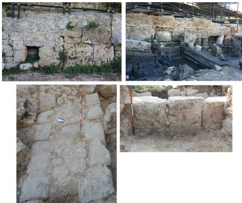
Fig. 6 San Vincenzo al V. Murature a grandi blocchi. Dall'alto in senso orario: avancorpo della basilica, recinto sul fiume, e strutture sul Colle della Torre
