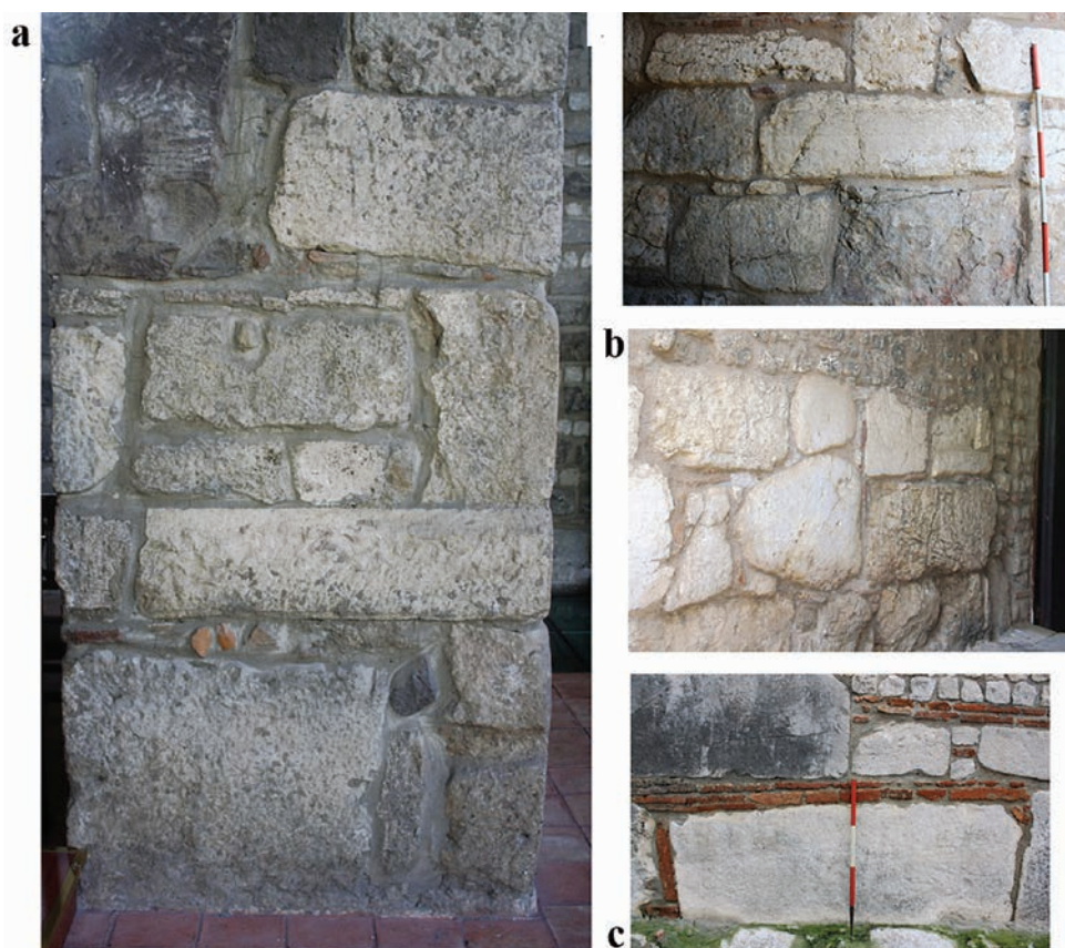
Fig.8 Murature a grandi blocchi. a. Pilastro dell'abbaziale del Salvatore (San Salvatore Telesino, BN); b. cortine interne della torre di Santa Maria di Compulteria (Alvignano, CE); c. basamento della torre campanaria della cattedrale di Telesia (Telesse Terme, BN).
