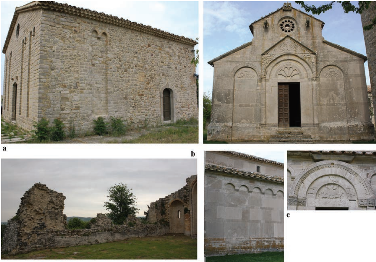
Fig. 11 a. Abbaziale di San Pietro (Sant'Elia a Pianisi, CB); b. Santa Maria di Casalpiano (Morrone del Sannio, CB), perimetrale sinistro; c. Santa Maria della Strada (Matrice, CB), facciata e particolari.
