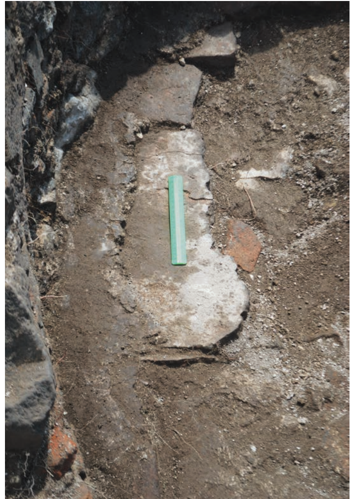
Fig. 19 - Tile bottom of the structure with a thin mortar layer (N. Busino).
