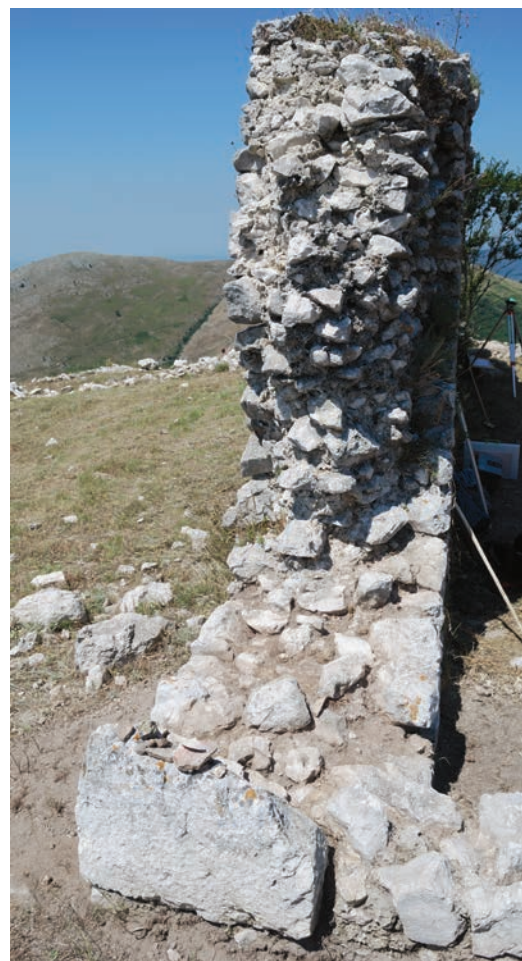
Fig. 11 - South perimeter wall of the medieval church (N. Busino).
