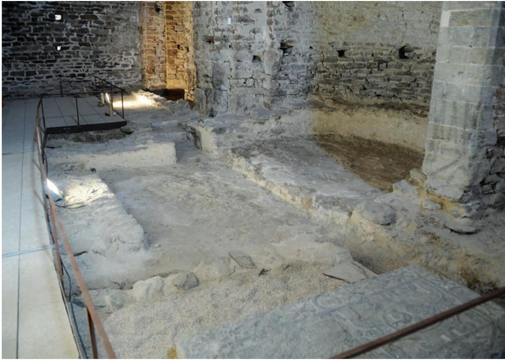
Fig. 21. Ábside mayor y centro del transepto con las estructuras visibles para sustentar las estructuras del coro alzado (ECLOC/LFA/D. Marcos)
