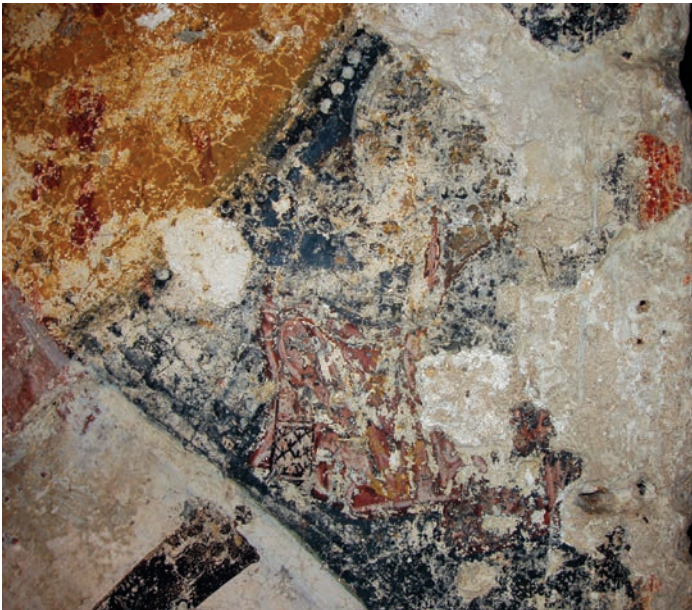
Fig. 8. Brindisi, chiesa della Santissima Trinità – Santa Lucia, cripta, particolare dell'affresco in figura 3 (foto dell'Autore).
