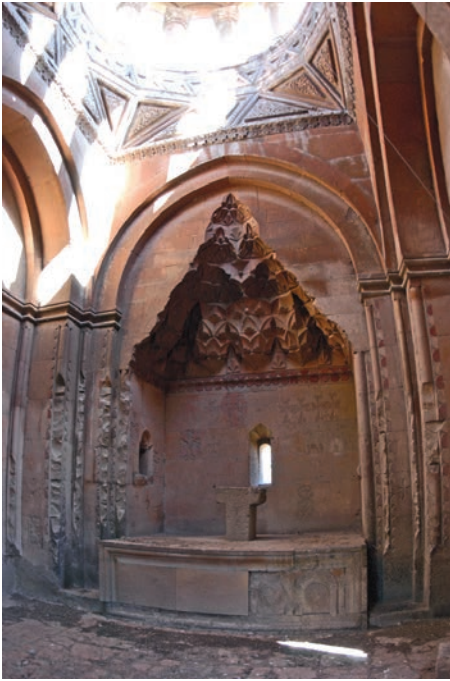
Fig. 7. Éghvard. Sainte-Mère de Dieu. Base intérieure de la rotonde. Caissons triangulaires et bandes d'étoiles (cl. Hraïr Khatcherian).
