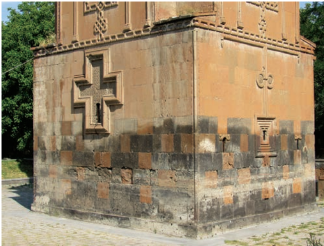
Fig. 16. Éghvard. Sainte-Mère de Dieu. Niveau inférieur ; vue du Sud-Est (cl. P. Donabédian).
