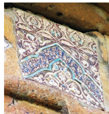
Fig. 45. Éghvard. Carreau Cat. 11, sur la face nord-est de la rotonde (cl. P. Donabédian).
