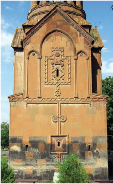
Fig. 17. Éghvard. Sainte-Mère de Dieu. Façade est (cl. P. Donabédian).
