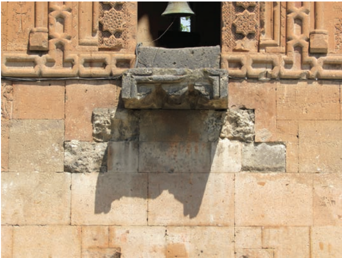
Fig. 8. Éghvard. Sainte-Mère de Dieu. Porte du niveau intermédiaire. Seuil saillant et début d'escalier suspendu (cl. P. Donabédian).
