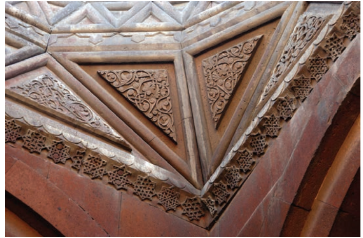
Fig. 6. Éghvard. Sainte-Mère de Dieu. Intérieur du niveau intermédiaire ; vue vers l'Est : la niche-abside à stalactites (cl. Hraïr Khatcherian).
