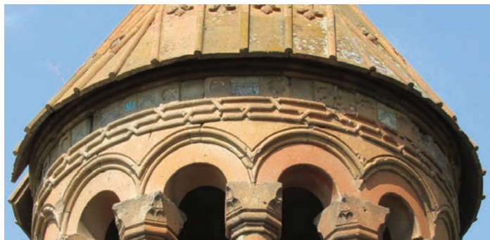
Fig. 33. Éghvard. Sainte-Mère de Dieu. Face orientale de la rotonde (cl. P. Donabédian).
