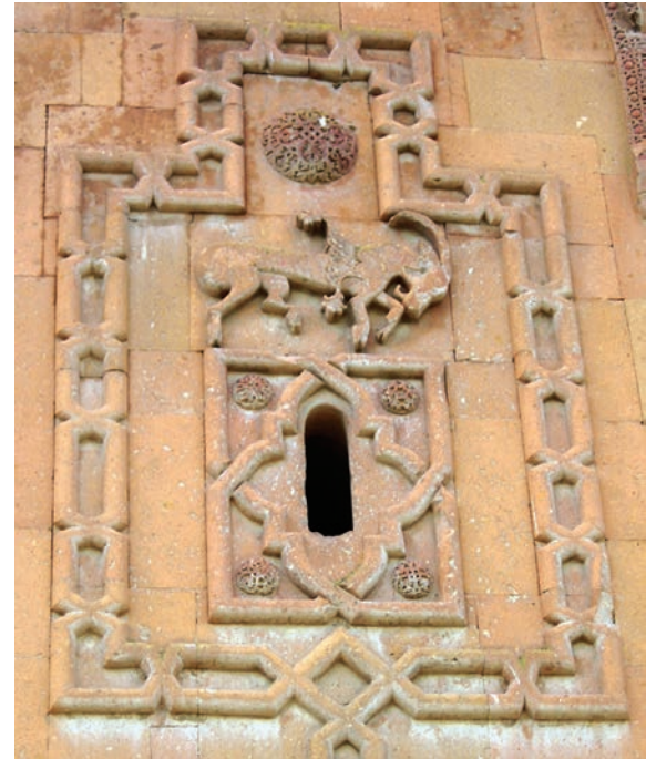
Fig. 27. Éghvard. Sainte-Mère de Dieu. Centre de la façade nord (cl. P. Donabédian).
