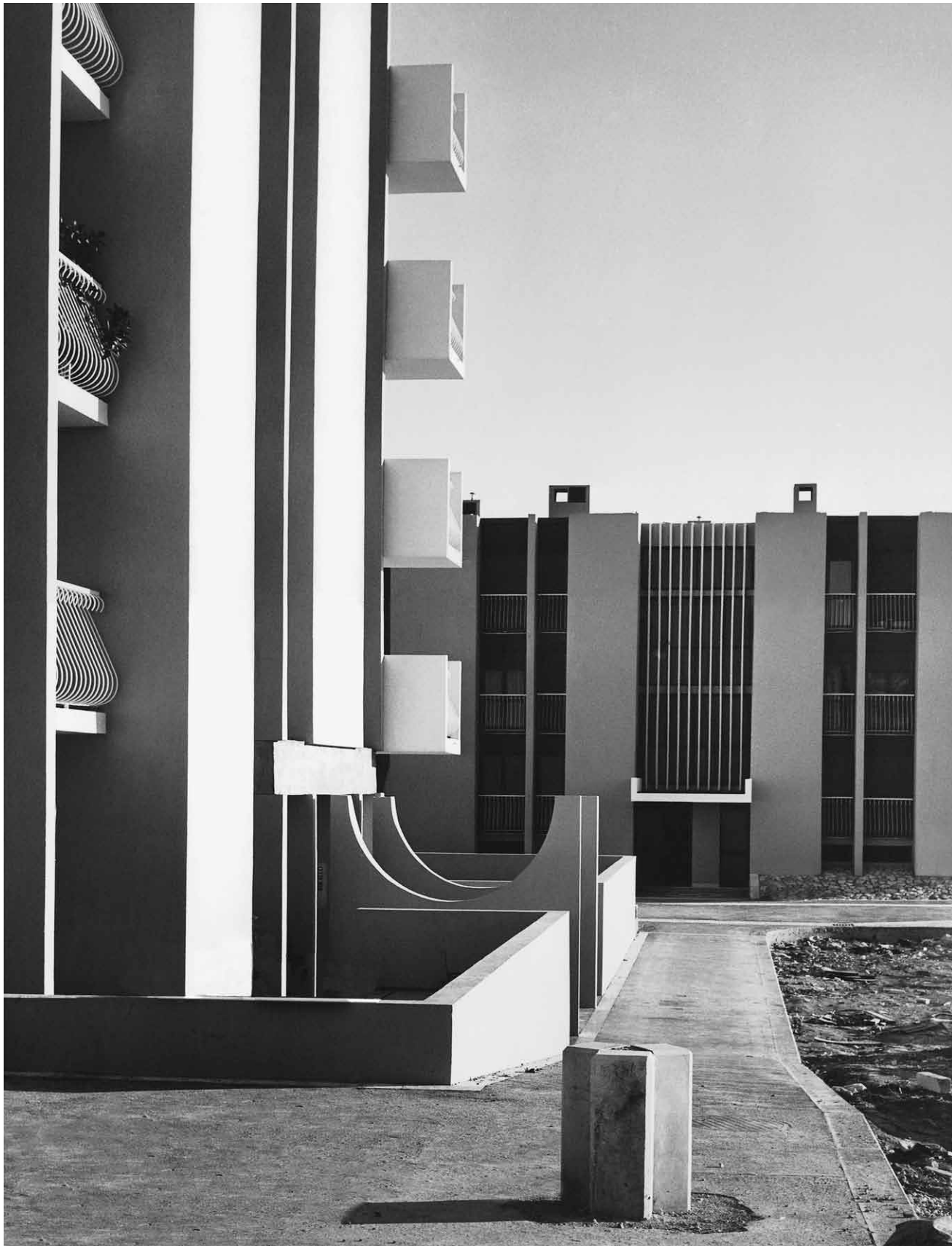
Detalj: Ulica braće Borozan
