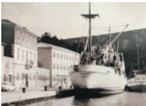
Slika 3. Zgrada Klesarske škole u periodu nakon izgradnje – školske godine 1958./59.
