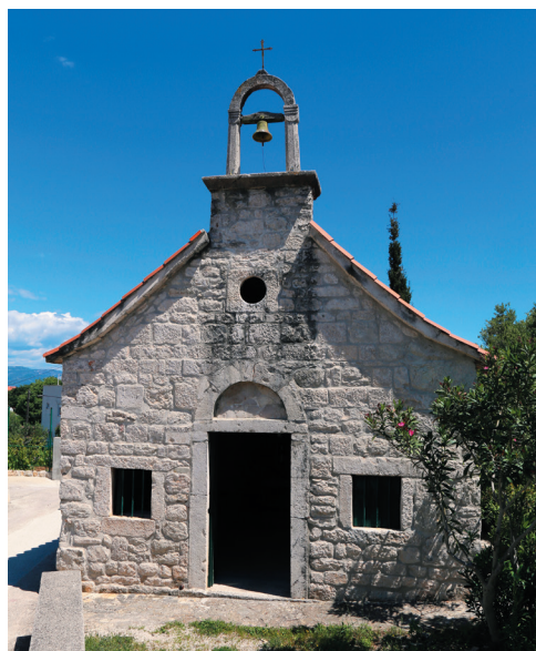
Pročelje crkve sv. Andrije na Čiovu
