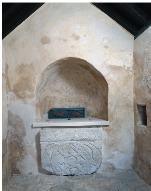
Pogled na svetište crkve sv. Bartula nakon uređenja
