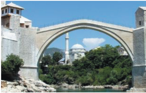
Sl.1. Mostarski most neposredno nakon uklanjanja skele
