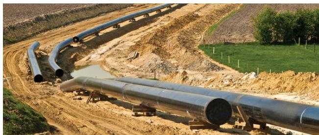
**U** proteklih mjesec dana započeti su radovi na izgradnji dva nova magistralna plinovoda: Omanovac – Daruvar i Knežinec – Varaždin II. Prvi plinovod, Omanovac – Daruvar, radnih parametara DN 150/50 i duljine oko 12,3 km, zamjenit će stari i dotrajali plinovod Pakrac – Daruvar na dionici od Oma-
