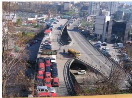
Slika 3 – Trenutno stanje vijadukta Koševo
