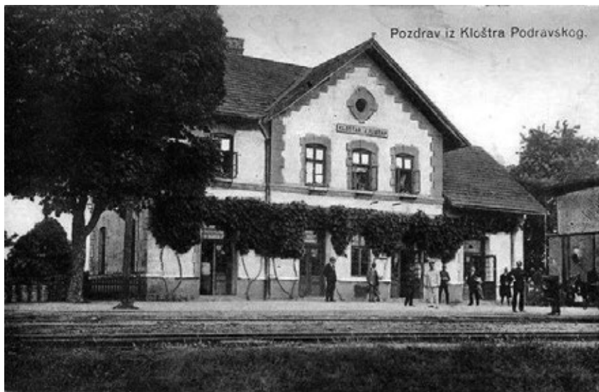
Slika 2. Željeznički kolodvor u Kloštru Podravskome
