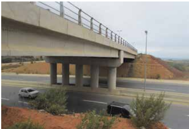
Slika 5. Pogled na analizirani most
