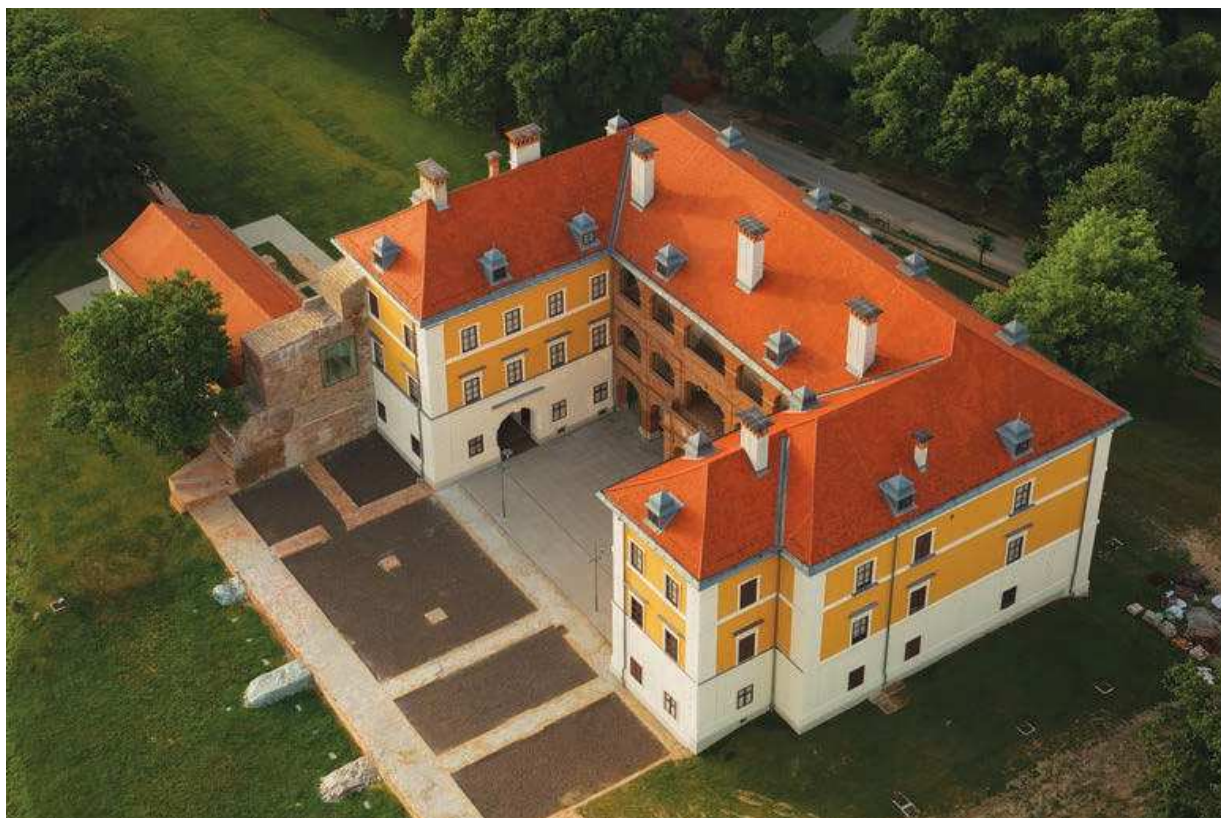
Muzej grada Iloka, Dvorac Odescalchi, zračni snimak, Hrvatski restauratorski zavod 2011.
