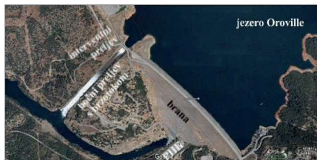
Slika 3: Brana Oroville s preljevima i pribranskom pumpno-reverzibilnom elektranom (Google-Earth)
