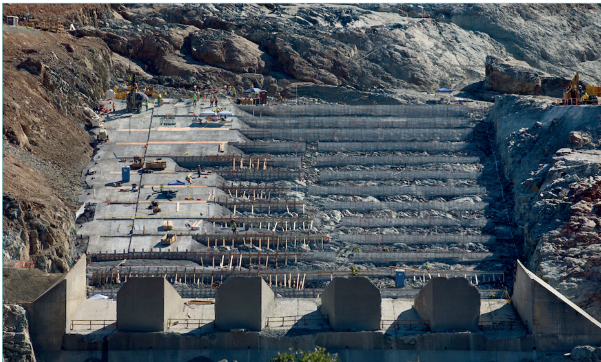
Slika 14: Ojačanje stijene u podlozi budućeg brzotoka (izvor: California Department of Water Resources; Kelly M. Grow; 21. 7. 2017.)
