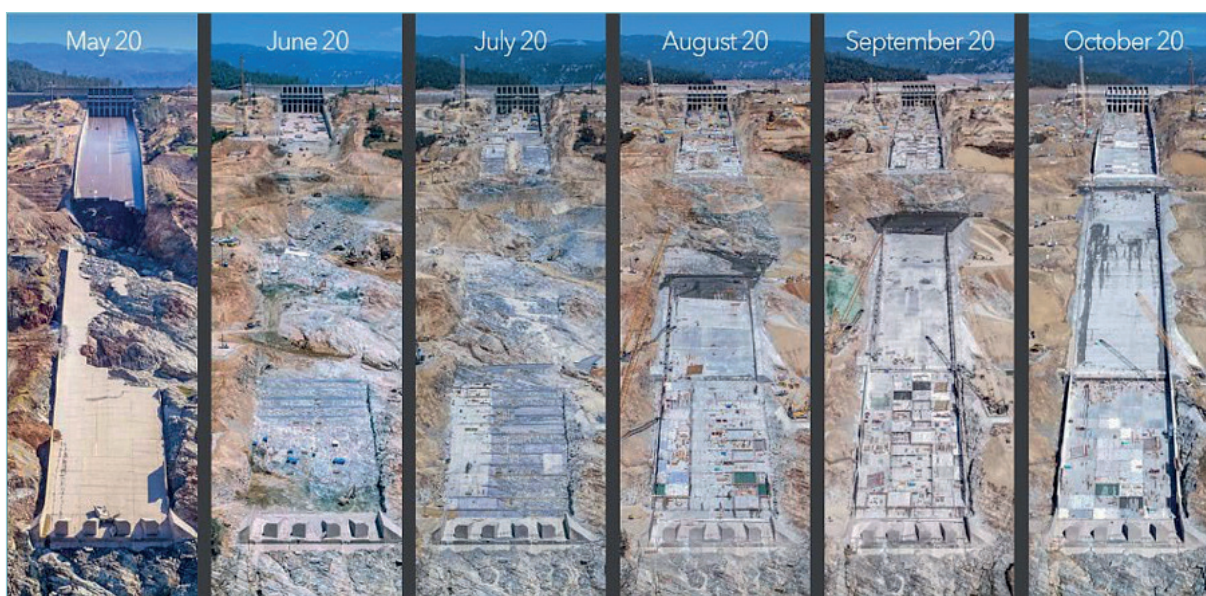
Slika 13: Vremenski slijed radova na obnovi bočnog preljeva (izvor: California Department of Water Resources; Kelly M. Grow; Ken James; Dale Kolke)
