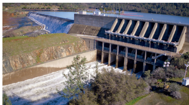
Slika 8: Početak rada interventnog preljeva 11. veljače 2017., voda teče i bočnim preljevom (California Department of Water Resources, Zack Cunningham, 11. 2. 2017.)
