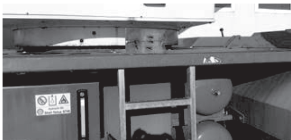
Slika 2. Neispravno postavljena drvena paleta
