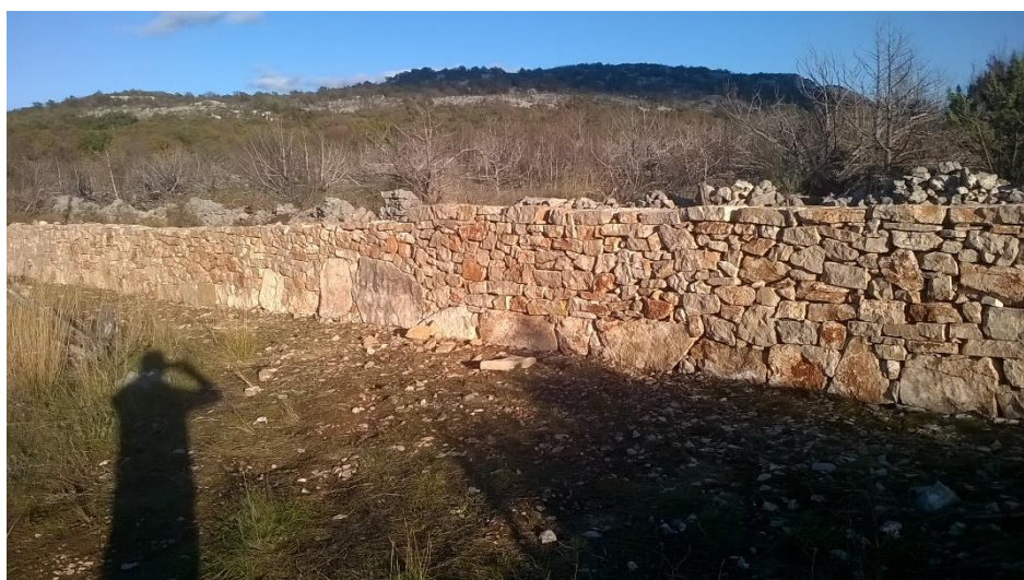
Slika 4. Podužni prikaz suhozida groblja obitelji Raguž u Hrasnom
