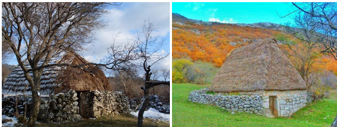
Slike 50.-51. Stara kamena kuća s tradicionalnim krovom na Bilima kod Mostara (lijevo); 34 Stara štala u Rakitnu, Posušje (desno) 28
