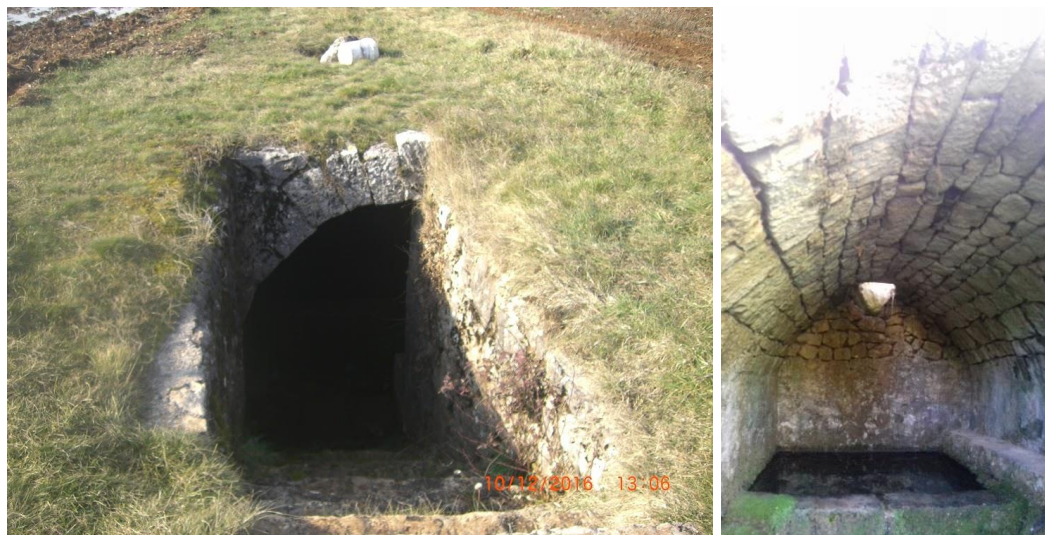
Slike 57.-58. Suhozidni čemer na podzemnom izvoru „Nova voda“ u Rastovačkom polju, Općina Posušje iz turskog razdoblja: ulazni dio sa stubištem (lijevo; foto: F. Oreč); Unutrašnjost bunara sa svodom od kamena (desno; foto: K. Šaravanja)
