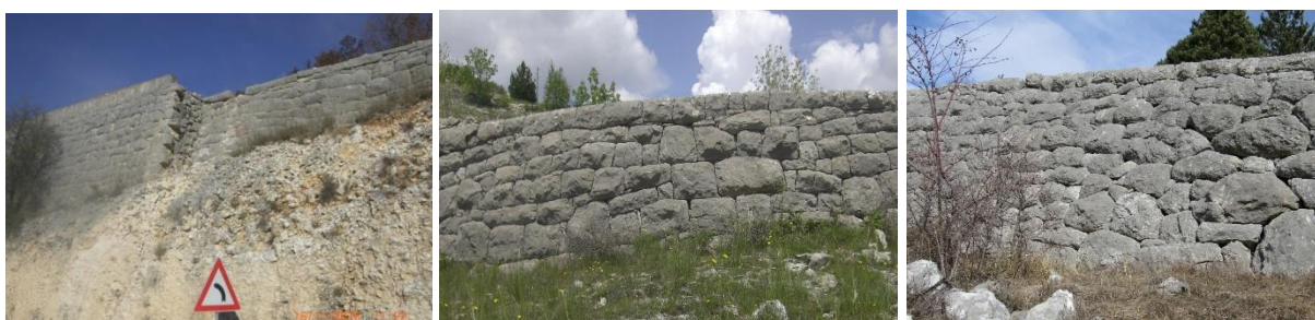
Slike 24.-25. Zaplanik, Trebinje (lijevo); Diklići, Trebinje - „rampa“ za ulazak u vlak, u suhozidnom potpornom zidu (desno) (foto: Ivan Đurović) 26
