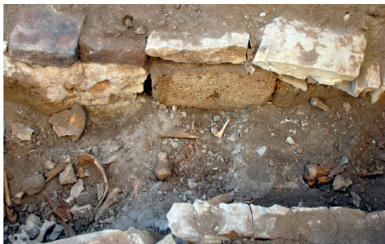
1: Blokovi opeke i sedre ugrađeni u konstrukciju groba br. 19 u crkvi sv. Petke
