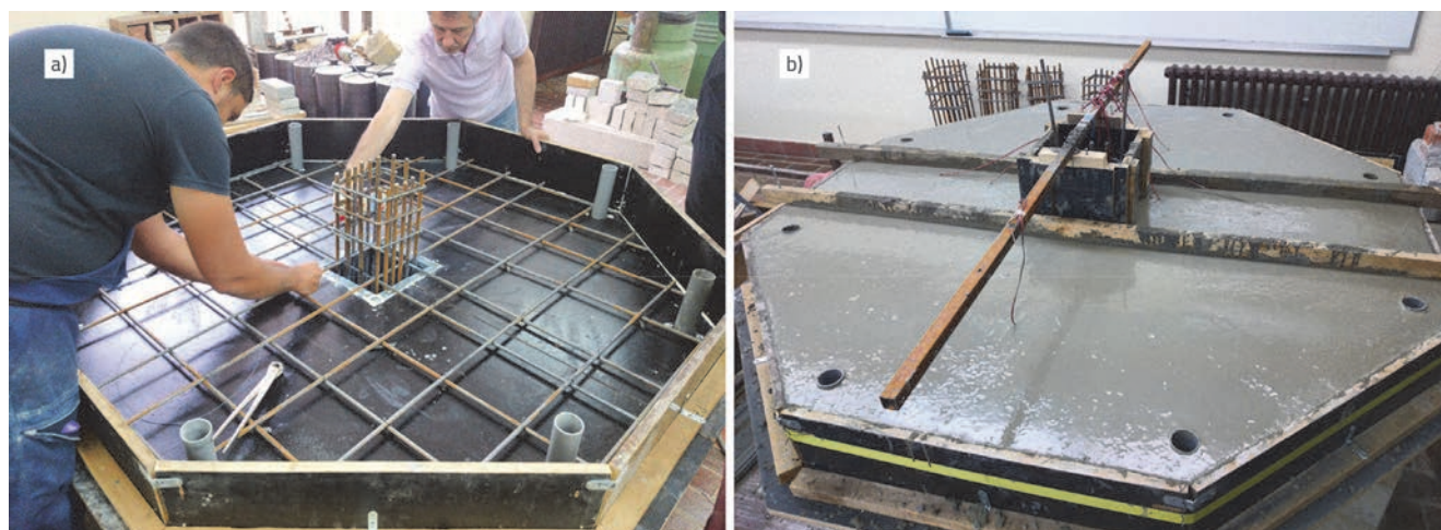
Slika 7. Priprema uzorka: a) Postavljanje armature; b) Uzorak nakon ugradnje betona
