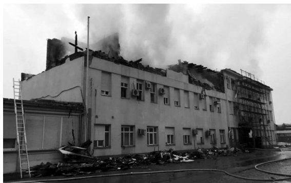
Slika 2. Tragovi požara s vanjske strane objekta
