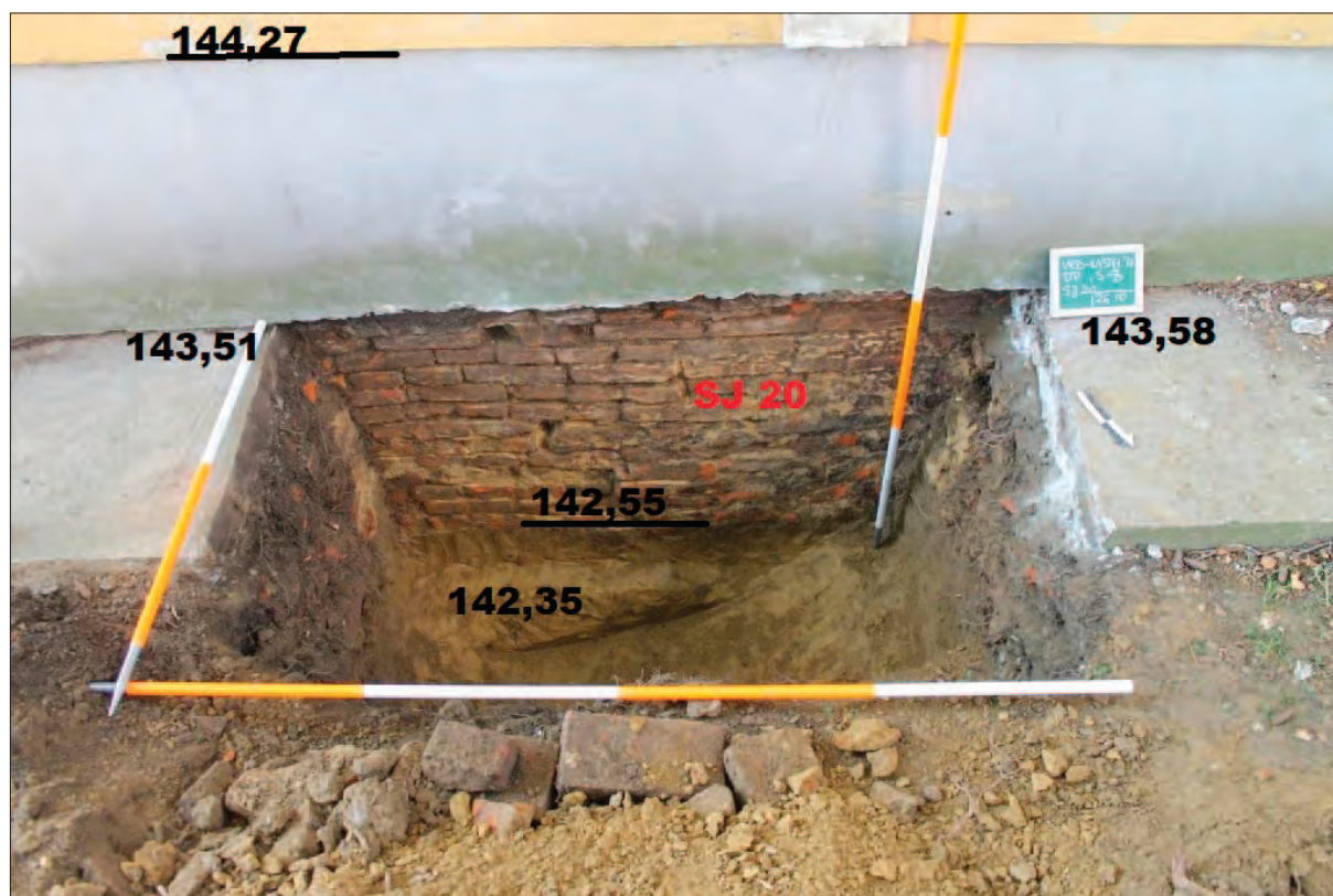
Sl. 7 Dvor Patačić, sonda 3, pogled na temelje SJ 20 sa sjevera (snimila: T. Tkalčec)
