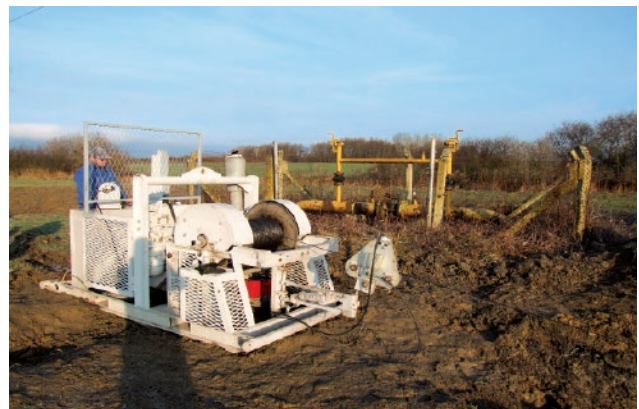
Slika 4. Vitlo za uvlačenje fleksibilne cijevi
