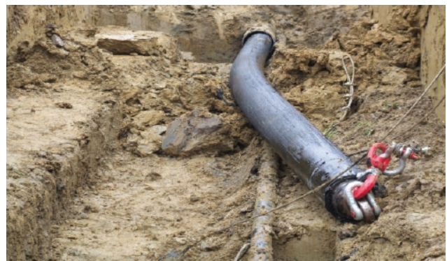
Slika 5. Fleksibilna cijev nakon uvlačenja
