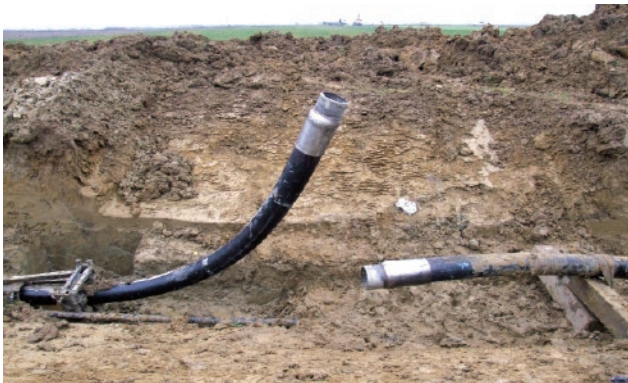
Slika 7. Jedna jama sa dvije fleksibilne cijevi s spojnicama
