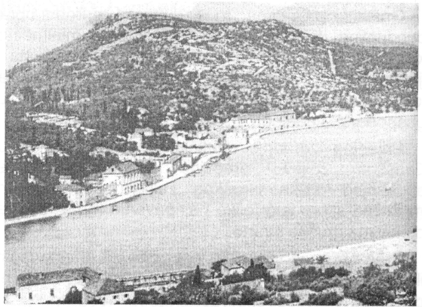
Slika 9. Izgrađena obala na lapadskoj strani zaljeva Figure 10. The quay constructed along the Lapad side of the bay
