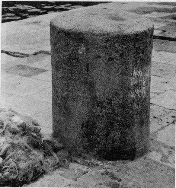
Slika 2. Kasnoantički ulomak stupa od sijenita (visina 65,5, širina 51 cm) sekundarno upotrijebljen kao kolona na Gatu Ponta u Gradskoj luci. Opaža se kosina koja je služila za učvršćivanje kapitela. (Snimio: A. Ničetić)
