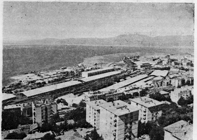
Riječka luka (u prvom planu gradilište kontejnerskog terminala)
