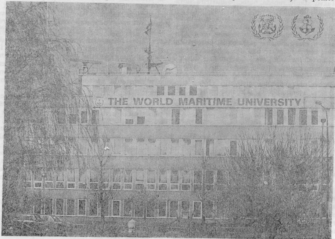
Zgrada Svjetskog pomorskog sveučilišta u Malmö — World Maritime University
