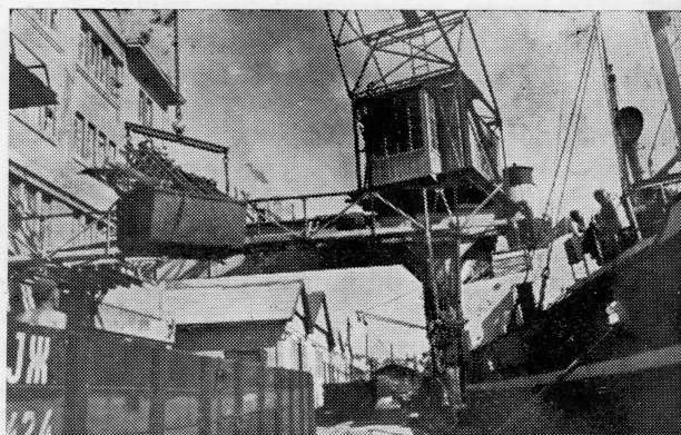
Gruška luka (1959), pogled na skladišta i mehanizaciju
