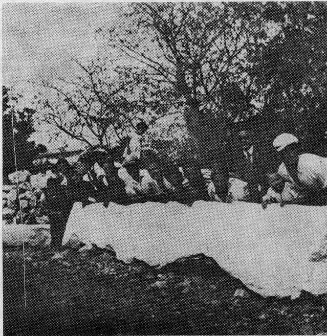
Kameni blok dug 7 metara doprema se iz kamenoloma na gradilište
