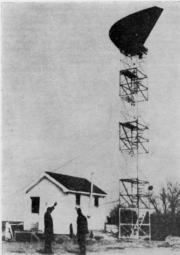
Eksperimentalna radarska stanica Ratan u Sandy Hook-u ima paraboličan rotirajući radarski davač (reflektor) širine 7,5 m za zonu između Narrows-a i Ambrose
