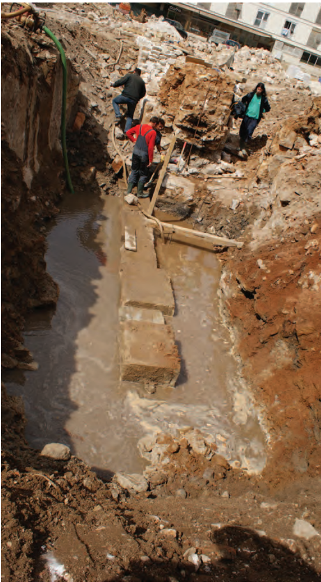
Sl. 2 Ostaci temelja srednjovjekovnoga zida s rimskim bazama za kipove (foto: K. A. Giunio)
