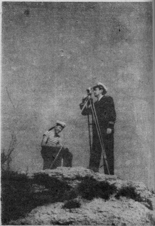
Osmatranje i uzimanje kuteva za triangulaciju
