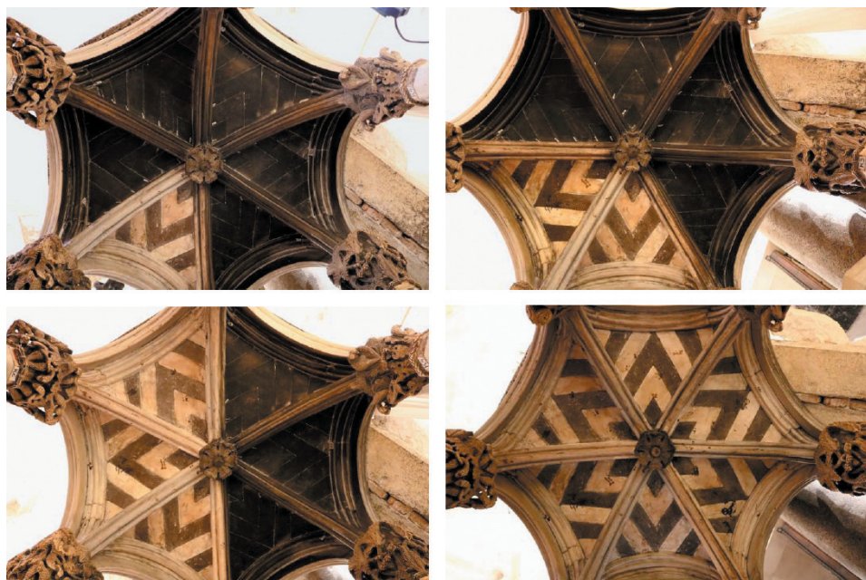
Tijek čišćenja svoda propovjedaonice
